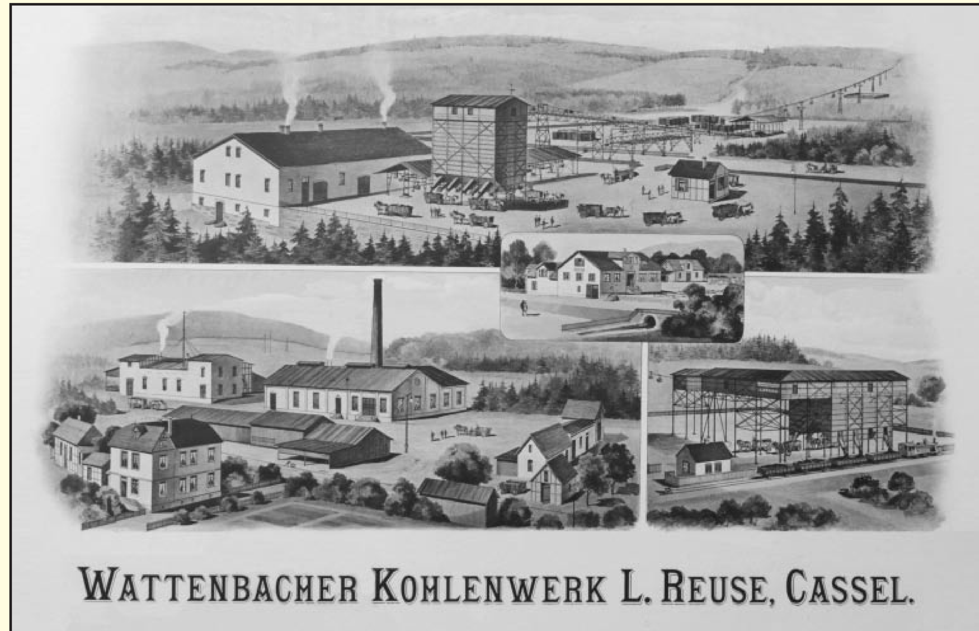
Die Lithografie bietet einen guten Überblick über das Wattenbacher Kohlenwerk. Das obere Bild zeigt die Grube „In der Lache“. Das Gebäude links beherbergte das Büro, die Werkstatt und den Maschinenraum für die Seilbahn, daneben sind der Verladebunker mit Seilbahn und das Wiegehaus erkennbar. Auf dem Bild links unten ist die Zeche „Alte Grube“ mit dem Maschinenhaus im Zentrum abgebildet. Das Gasthaus „Stellberg“ mit dem ehemaligen Förderstollen Stellberg-West ist auf dem mittleren Bild zu sehen. Unten rechts ist die Verladestation am Bahnhof Wellerode-Wald mit einem Kohlenzug der Söhrebahn dargestellt.
