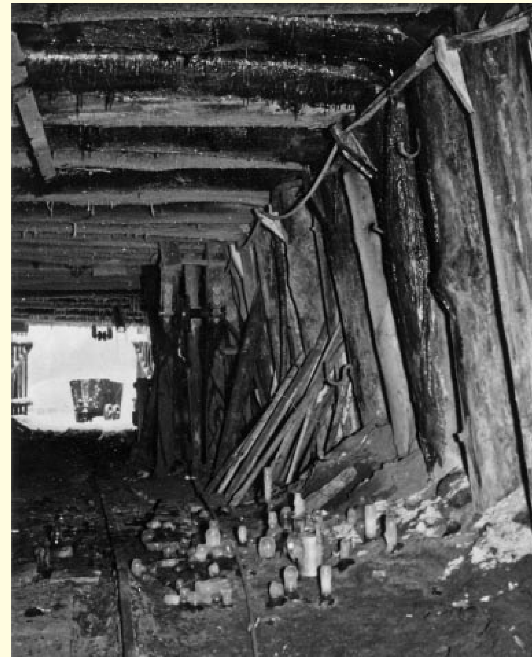
Blick aus einem Stollen. Deutlich ist der Ausbau mit Nadelhölzern (Deutscher Türstock) zu sehen, der den Bergdruck auffängt (um 1960).
