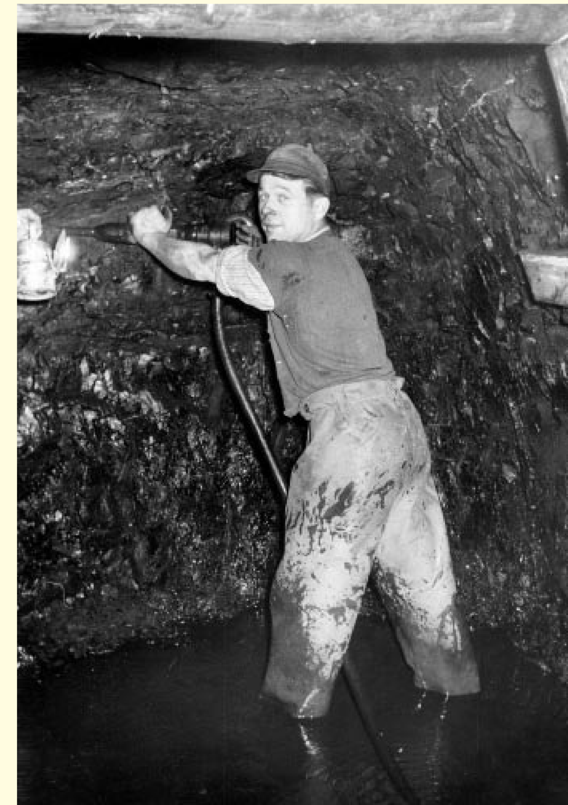
Bergmann bei der Arbeit. Die Kohlen mussten mit dem Presslufthammer heraus gebrochen werden. Das steigende Grundwasser war stets ein Problem im Stellberger Bergbau (um 1960).
