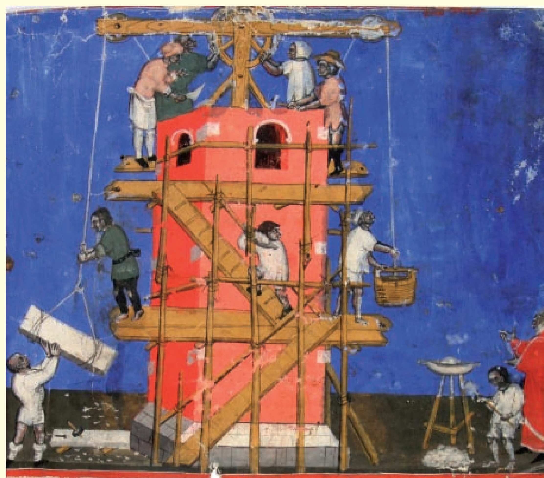
Die Buchmalerei von 1385 zeigt eine mittelalterliche Baustelle. Links neben dem Turmsockel hat ein Steinmetz mit Fäustel und Fläche (Hauwerkzeug zum Glätten) die Sandsteine zugerichtet, die mit einem Lastkran in die Höhe gezogen werden. Auf der rechten Seite zieht ein Arbeiter einen Korb mit Mörtel nach oben.
