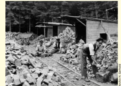
Steine wurden anschließend auf Loren verladen und zur Weiterverarbeitung transportiert. Steine minderer Qualität zerkleinerte man in Brechern zu Schotter. Den hochwertigen Basalt schlugen Steinrichter zu Pflastersteinen. Schotter und Pflastersteine fanden beim Eisenbahn- und Straßenbau Verwendung.
