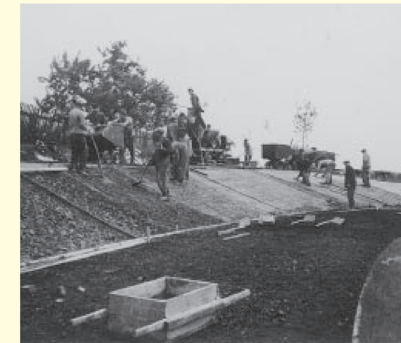
Ehrenamtliche Helfer leisteten zwischen 1946 und 1949 zahllose Arbeitsstunden beim Abtragen des Hangs und Aufbau der Langenbergkampfbahn. Für den Abtransport der Erde standen Loren auf behelfsmäßigen Schienen bereit.
