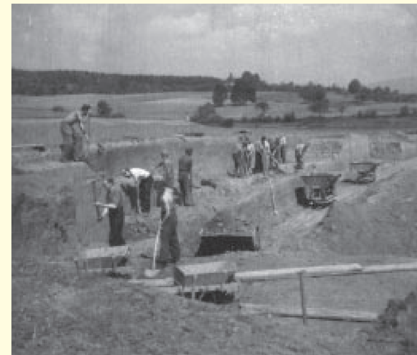
Ehrenamtliche Helfer leisteten zwischen 1946 und 1949 zahllose Arbeitsstunden beim Abtragen des Hangs und Aufbau der Langenbergkampfbahn. Für den Abtransport der Erde standen Loren auf behelfsmäßigen Schienen bereit.
