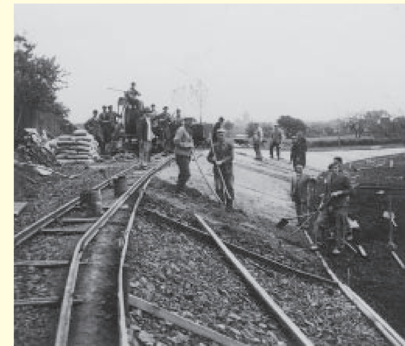
Ehrenamtliche Helfer leisteten zwischen 1946 und 1949 zahllose Arbeitsstunden beim Abtragen des Hangs und Aufbau der Langenbergkampfbahn. Für den Abtransport der Erde standen Loren auf behelfsmäßigen Schienen bereit.
