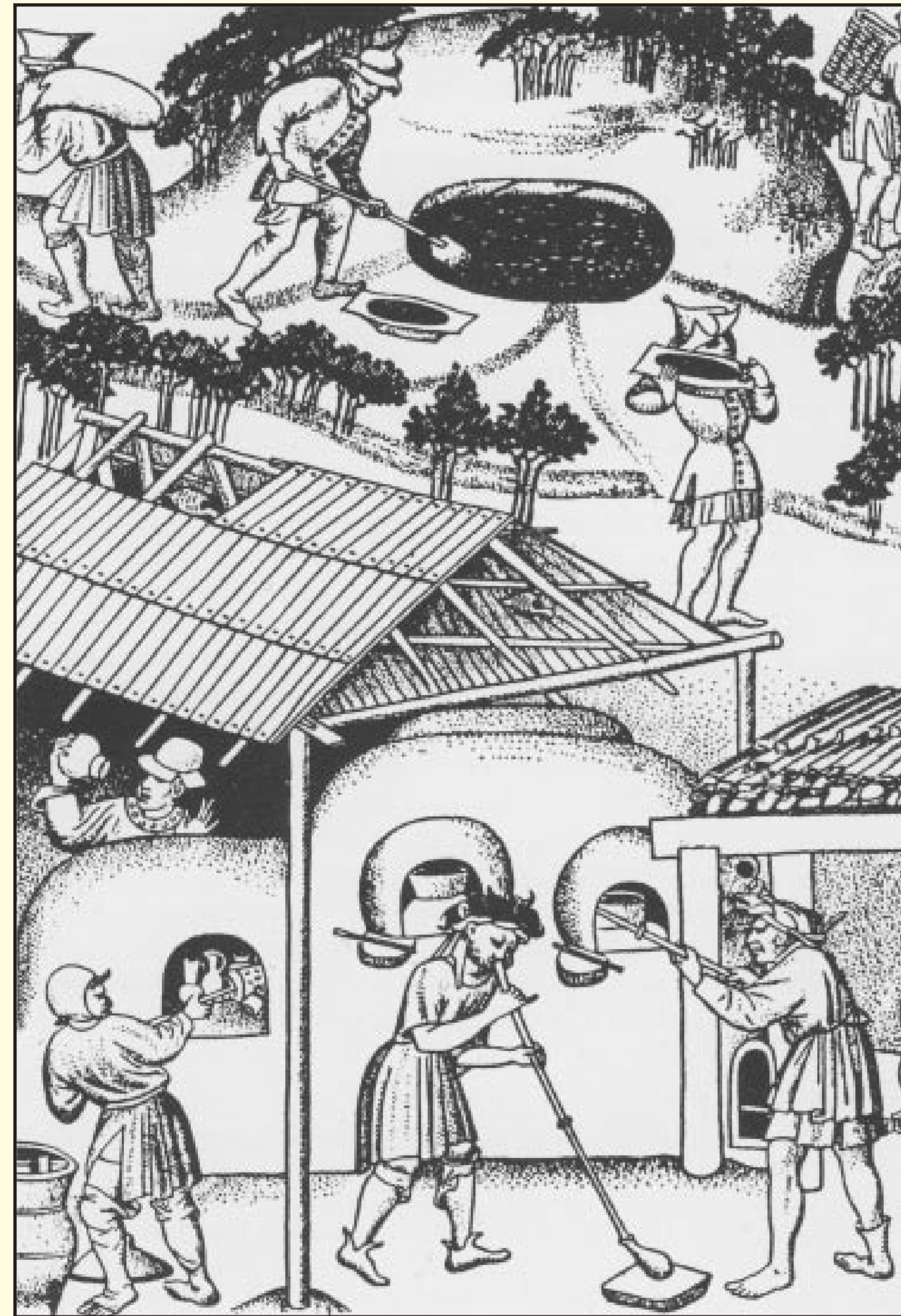
Umzeichnung einer Illustration zu den Reisebeschreibungen des Jean de Mandeville. Sie zeigt eine Glashütte des frühen 15. Jahrhunderts: Im Vordergrund arbeiten zwei Glasbläser am Hauptofen, daneben wird der Kühlofen mit fertigen Gläsern beschickt. Im Hintergrund bauen Arbeiter Sand oder Ton ab.
