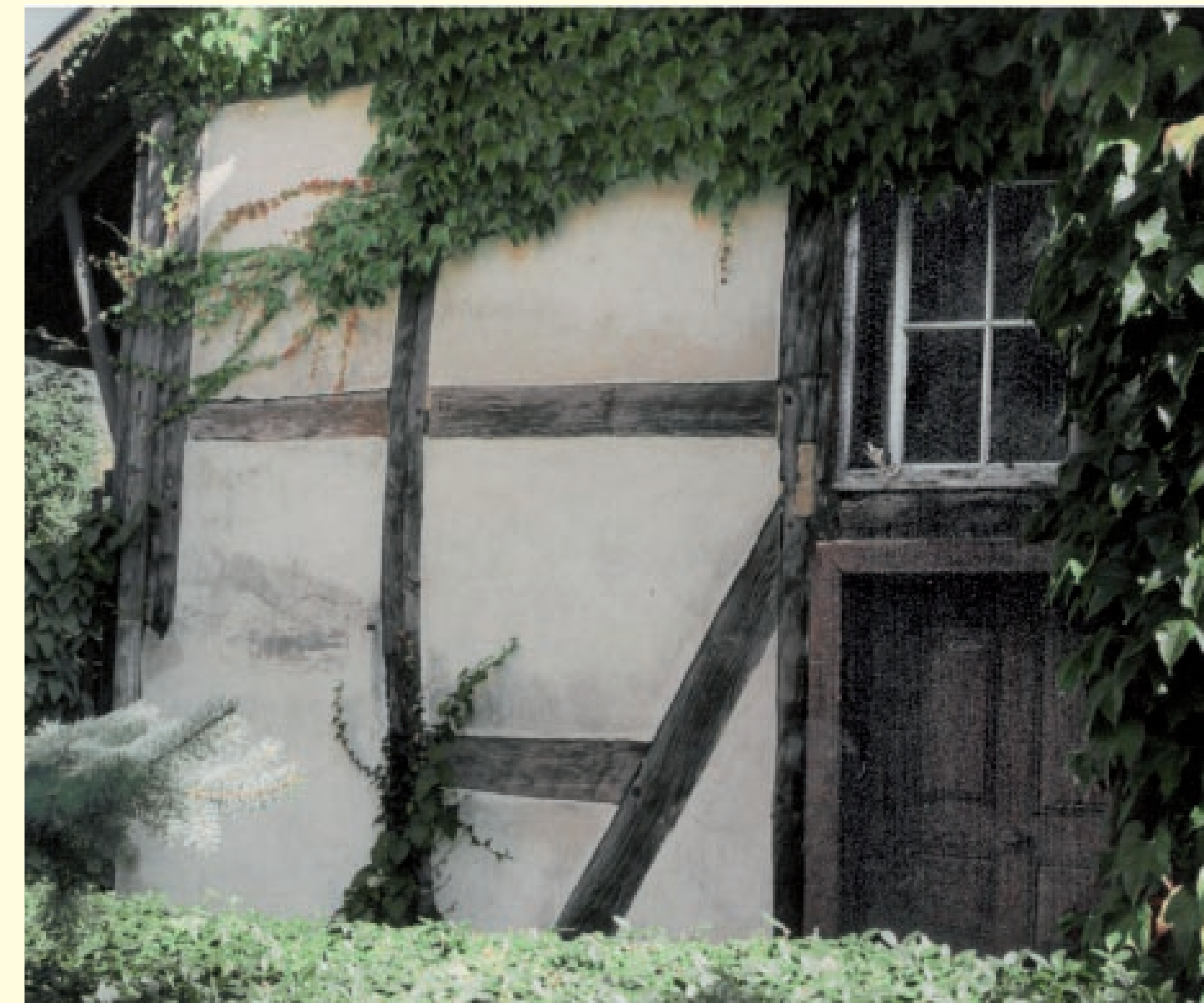
Die Synagoge Riede war ein Anbau des Hauses in der Elbenberger Str. 3. Sie bestand nur aus einem Raum.
