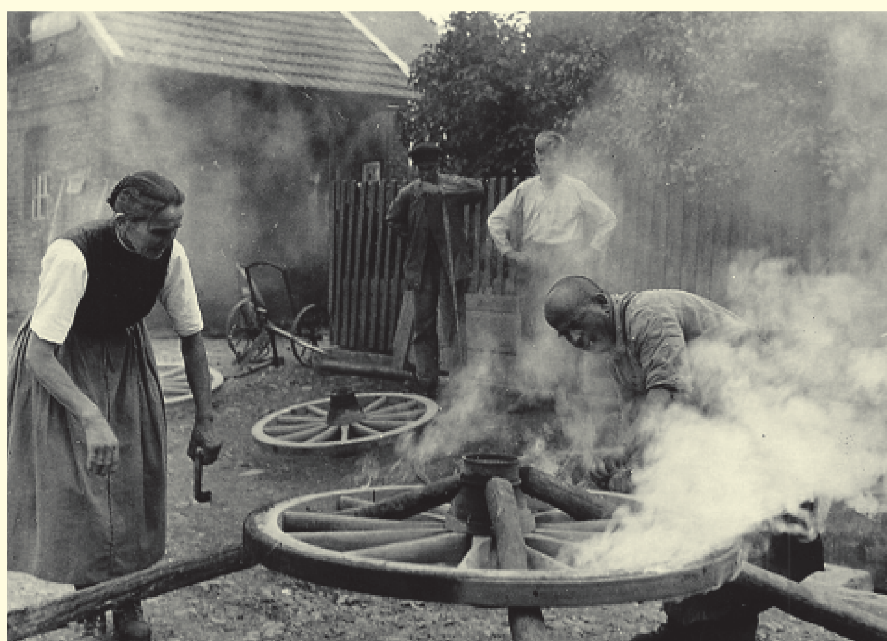
Schmied beim Aufziehen eines Reifens auf ein Wagenrad (hier in Niederdieten, 1935).
