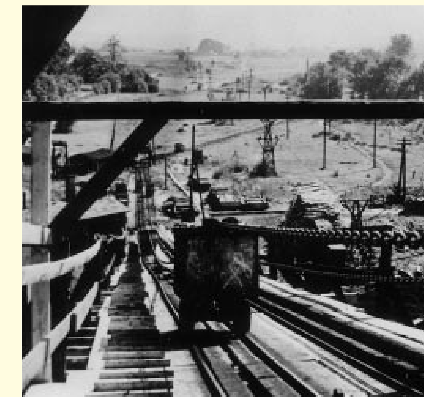
Kettenbahnanlage mit Hunten. Im Hinter- grund ist die Drahtseilbahn zur Zeche Oster- berg zu erkennen.
