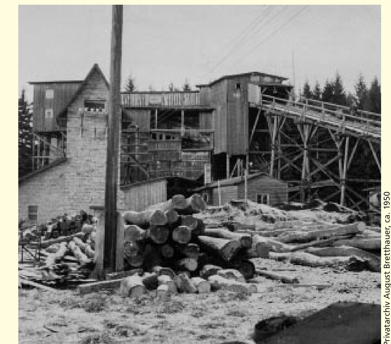
Die Kohle wurde in der Siebanlage in 5 Sorten vom Grus bis zur Stückkohle klassiert, d. h. nach Größe getrennt.
