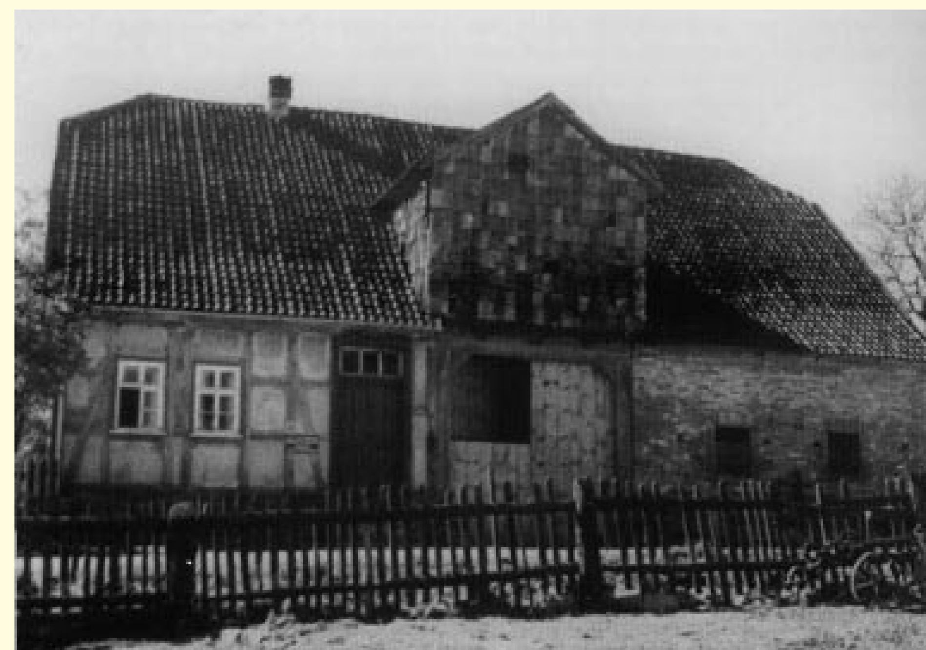
Wohnhaus von 1778 in weitgehend originalem Zustand. Der Zwerchgiebel ist nachträglich verkleidet.
