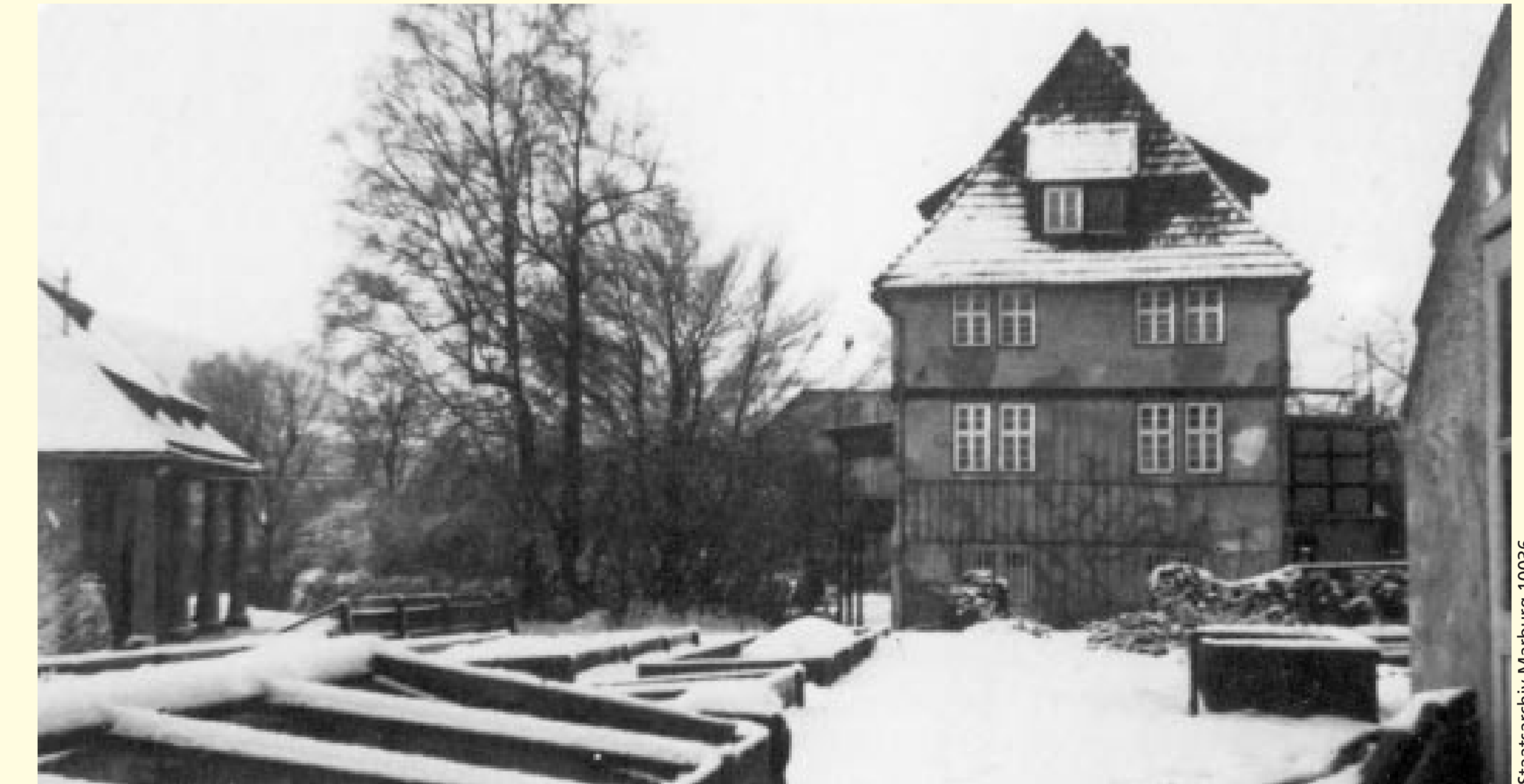
Das sogenannte Herrenhaus musste in den 1970er Jahren wegen Bau-fälligkeit abgerissen werden. Das Magazin (links) ist eines der wenigen erhaltenen Gebäude.
