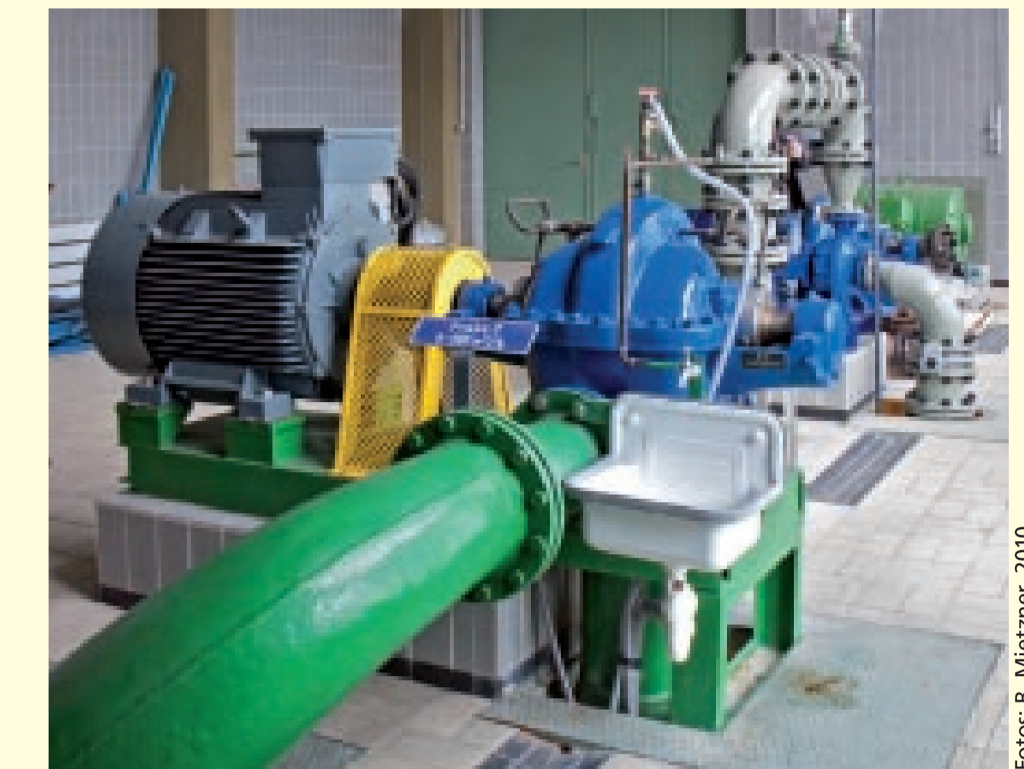
② Die Druckpumpe befördert das Trinkwasser zu den Hochbehältern.
