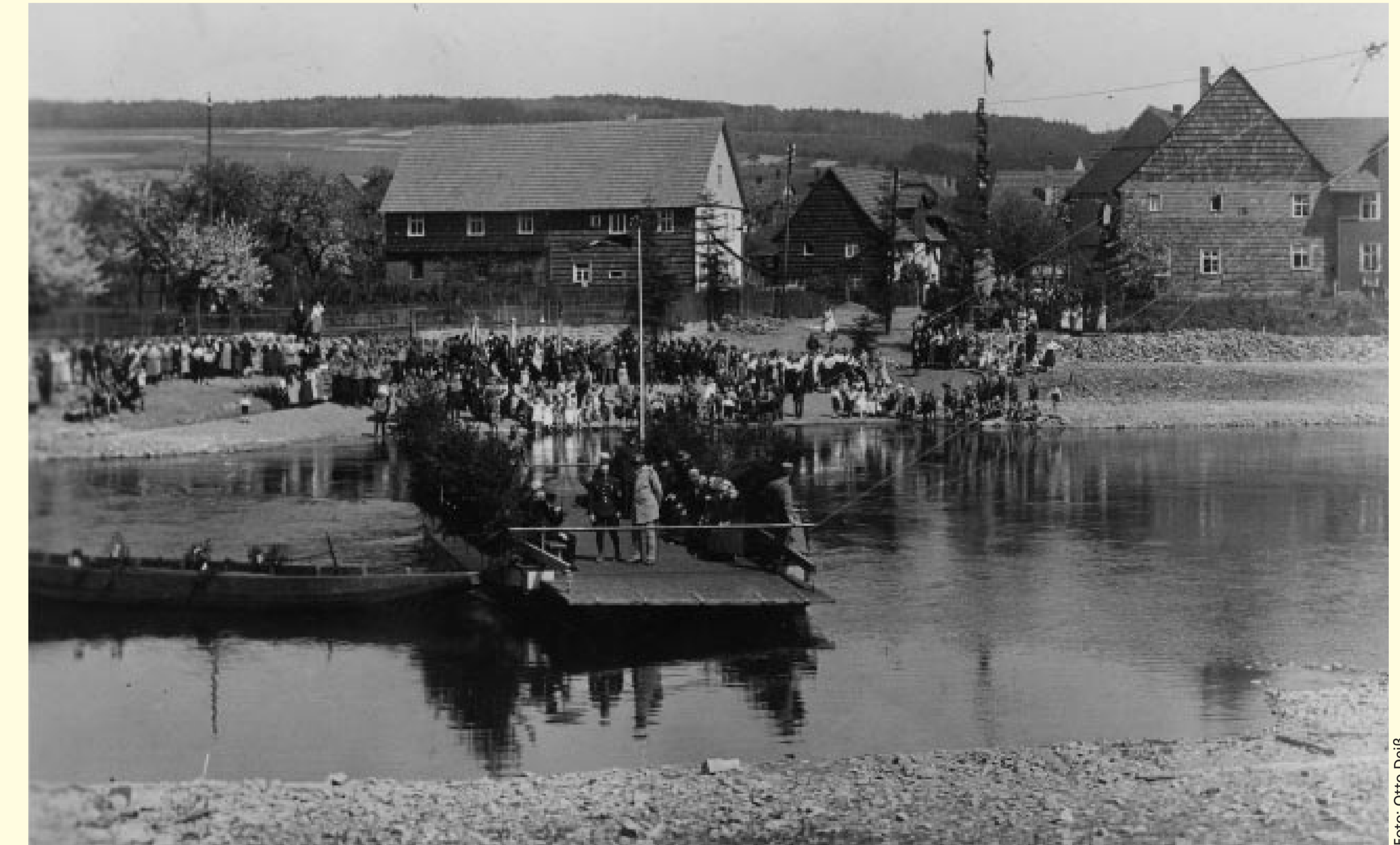
Zur Einweihung der Gierseilfähre am 1. Mai 1934 durften alle Einwohner des Dorfes, die siebzig Jahre und älter waren, kostenlos die Weser überqueren.
