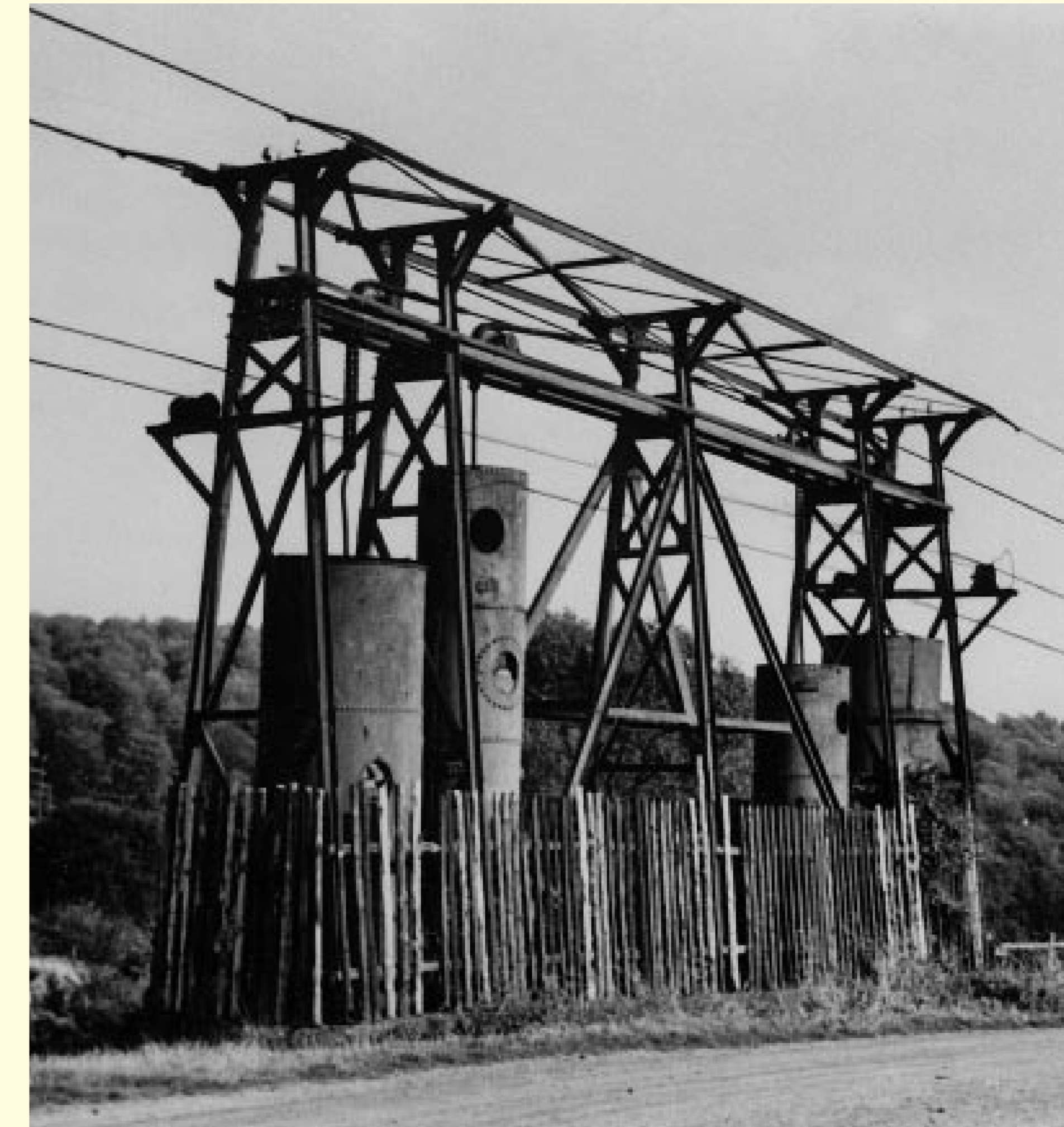
Der Spannbock hielt die Drahtseile gespannt. Die vier Gegengewichte waren mit Steinbrocken gefüllt und über Gliederketten mit den Trageile verbunden. Wurden die Trageile durch die Kohleloren stark belastet, gingen die Gegengewichte nach oben, bei wenig Last senkten sie sich wieder ab.
