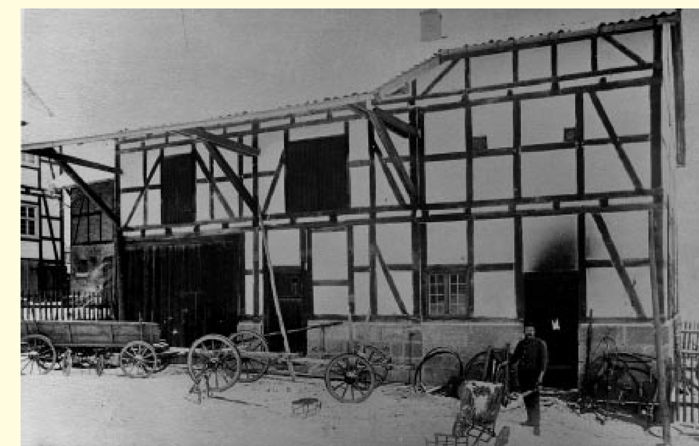
Johannes Kilian, rechts im Bild, musste um 1847 sein Haus für den Bau des Bahndamms abtragen. An dieser Stelle baute er sein Wohnhaus wieder auf und fügte seine Schmiede an.
