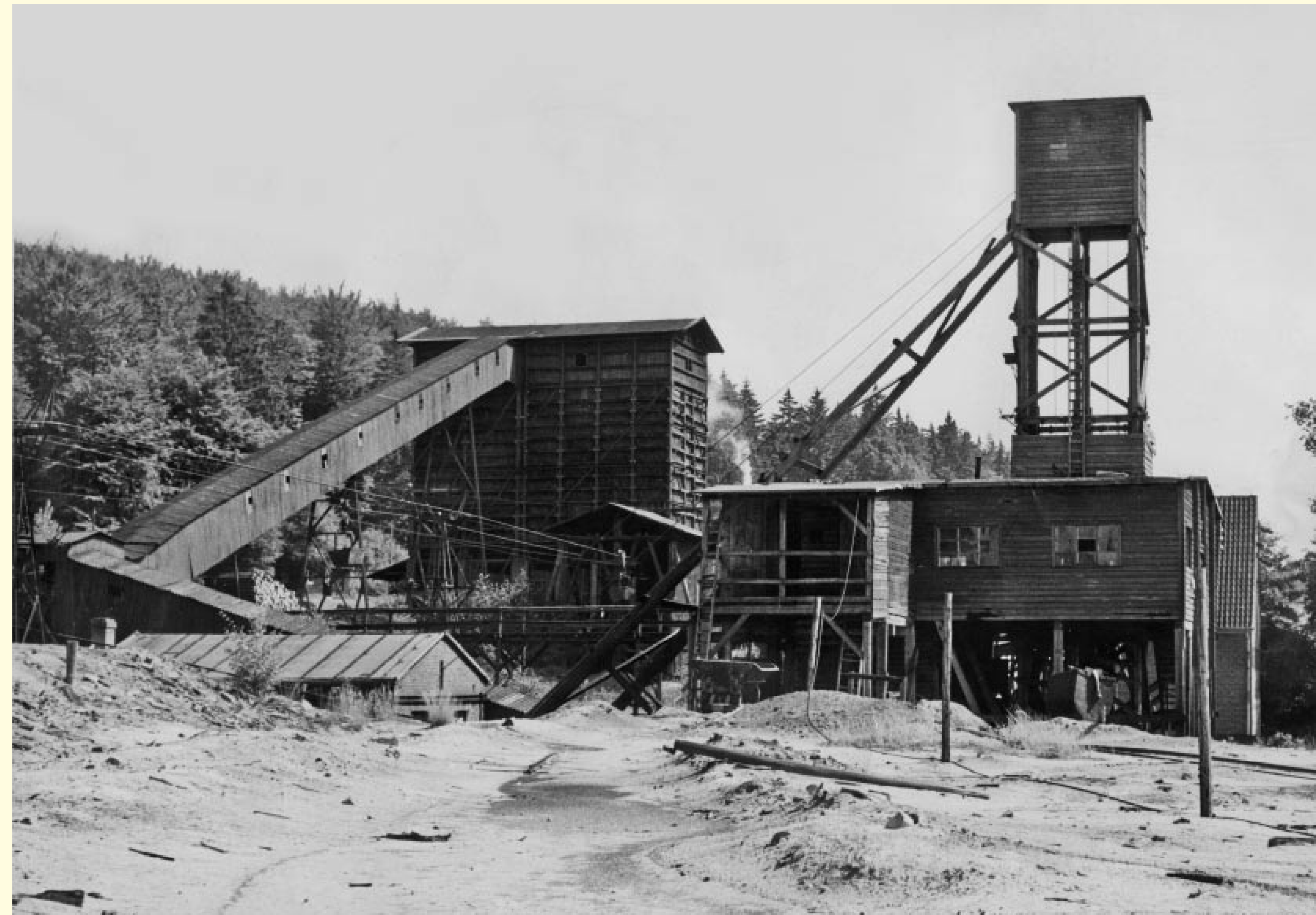
Zeche Wiesenschacht. Ein Aufzug (Turm) brachte die vollen Förderwagen nach oben. Von dort transportierte ein Band die Kohlen in den Verladebunker (links im Bild). Eine Seilbahn brachte den Rohstoff zur Verladung zum Bahnhof nach Wellerode-Wald (um 1960).
